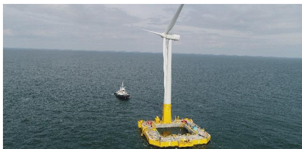
Floatgen à son arrivée sur SEM-REV le 30 avril
